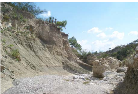
Efecto del intemperismo y la erosión en afloramientos de la formación San Juan Raya, en la localidad Barranca Grande, Puebla. Fotografía: Quiroz-Barroso, S.A.
