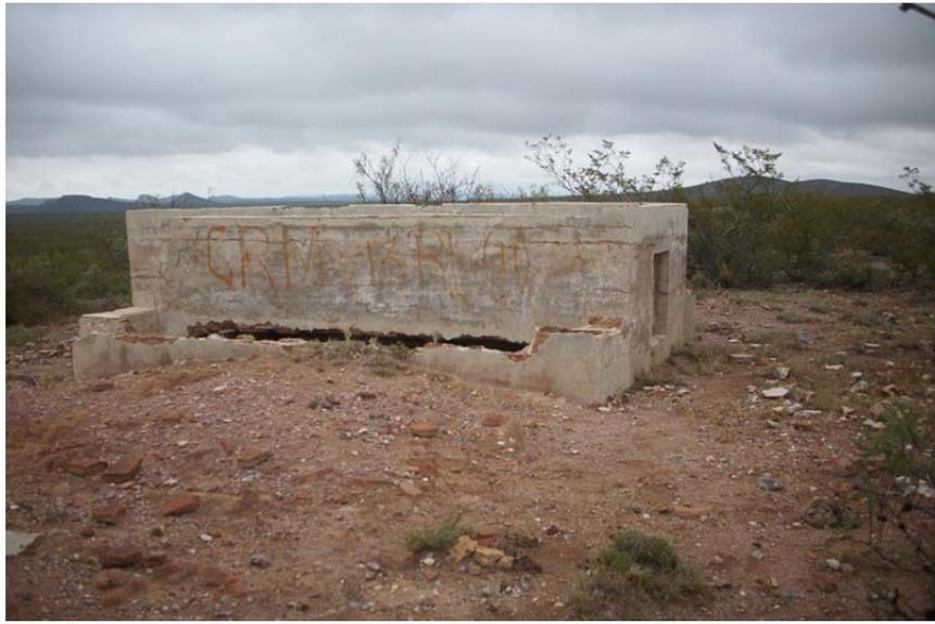
Fotografía 14. Fundición de mineral de mercurio, hacia la base se observa el hueco en donde se encontraba la tubería que captaba el mercurio líquido.
