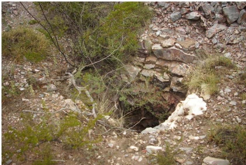
Fotografía 15. Tiro excavado en calizas intercaladas con lutitas en la localidad Loma Blanca.
