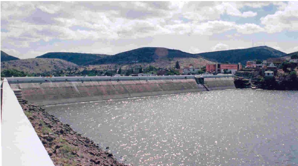
Fotografía 2 Presa Álvaro Obregón Mexquitic de Carmona, S.L.P.
