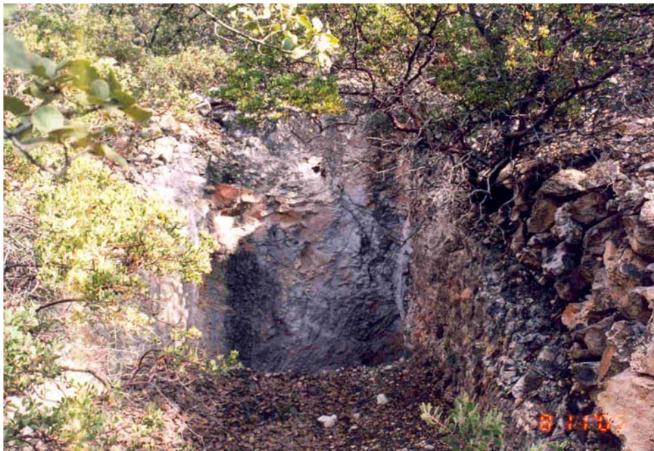
Fotografía 28. Pozo Hermenegildo, donde se observa el poco desarrollo
