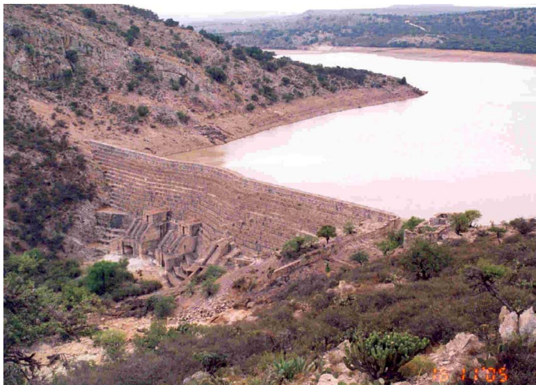
Fotografía 32. Panorámica de la presa Santa Genoveva, utilizada para riego, abrevadero y consumo de las rancherías.
