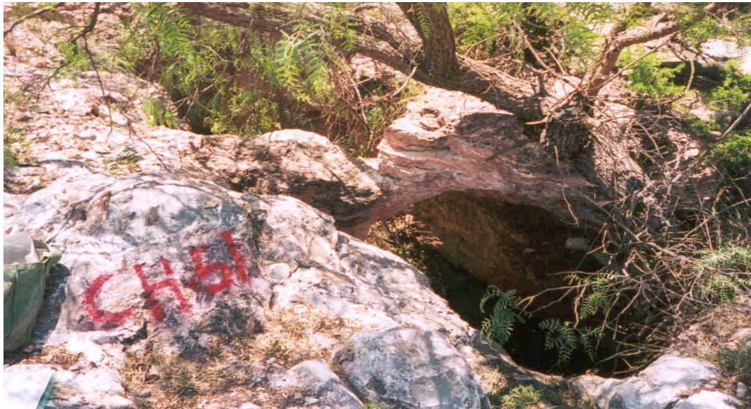
Fotografía 12. Mina El Socorro, actualmente azolvada, labrada a rumbo de un manto de mercurio con NE 48° SW.
