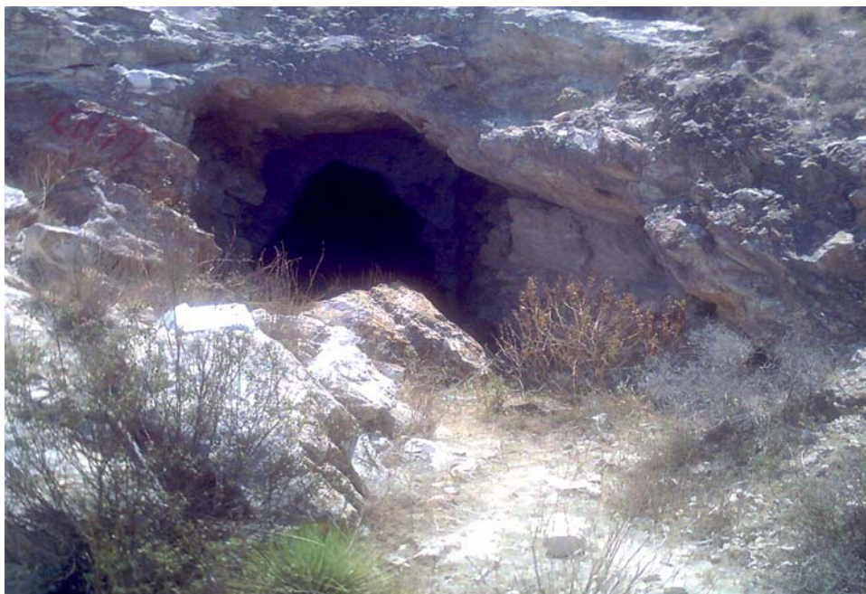
Fotografía 15. Socavón Las Eulalias, labrado en roca caliza, obra de exploración cortando veta y manto con baja mineralización.
