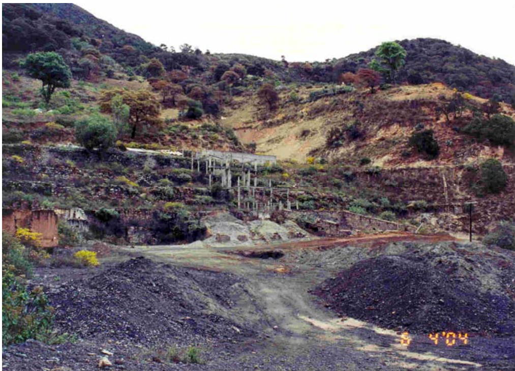
Fotografía 18. Patio de mina El Socavón, al fondo estructuras de lo que fue la planta de beneficio.
