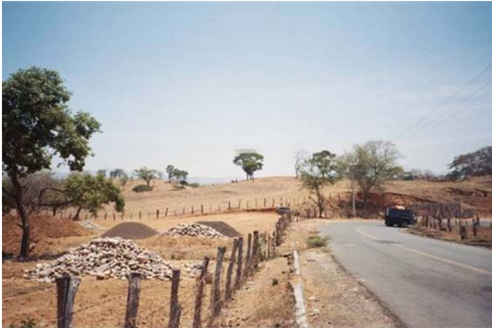
Fotografía 14. Al fondo, corte en el depósito de arcillas El Salitre 1
