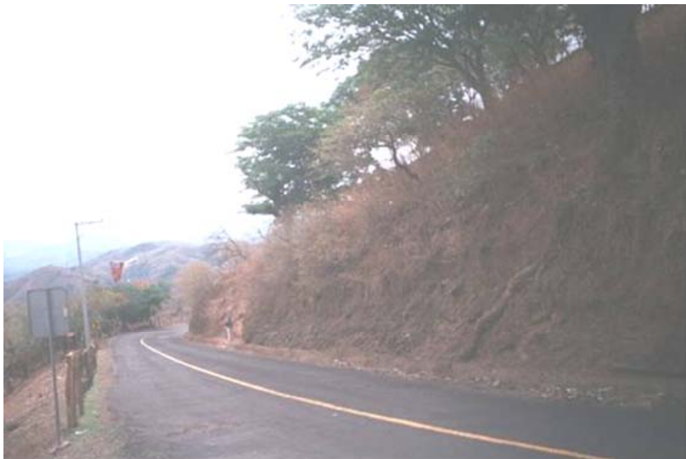
Fotografía 21. Corte en la carretera de las arcillas Puente Viejo
