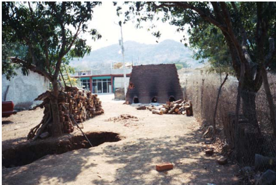
Fotografía 17. El Palmar, depósito de arcillas y obrador.
