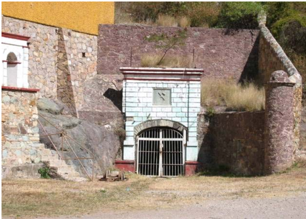
Fotografía 30. Mina Sirena, encontrándose en la falla de la Veta Madre, perteneciente al mismo sistema de vetas.
