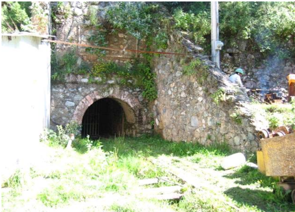
Fotografía 28. Bocamina de la localidad San Amado, propiedad de la Compañía Minera del Cubo, concesionada a Ing. Landino Marcocchio P.
