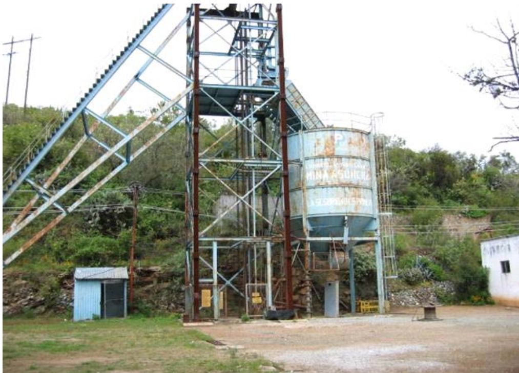
Fotografía 24. Instalaciones de la mina Asunción, actualmente inactiva y fue trabajada por la Compañía Minera Las Torres.
