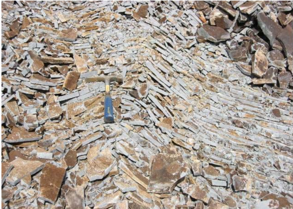
Fotografía 15. Andesita-basalto, afectada por un intenso sistema de diaclasas, con un espesor de más de 45 metros.
