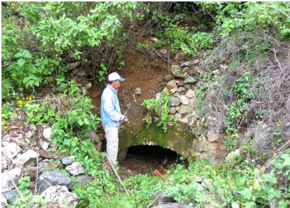
Fotografía 20. Bocamina del Tiro Rul, con un desarrollo de 70 metros y se encuentra labrada en la secuencia de rocas vulcanosedimentarias.
