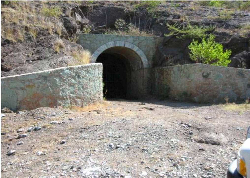
Fotografía 29. Acceso principal de la mina San Alberto, donde se tiene cuatro vetas que son San Alberto, Santa teresa, San Francisco y El Cubo.
