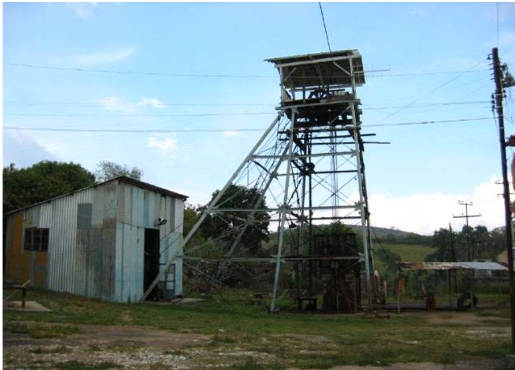
Fotografía 19. Acceso principal, tiro San Ignacio con un diámetro de cinco metros y una profundidad de 220 metros, con dos niveles en operación.
