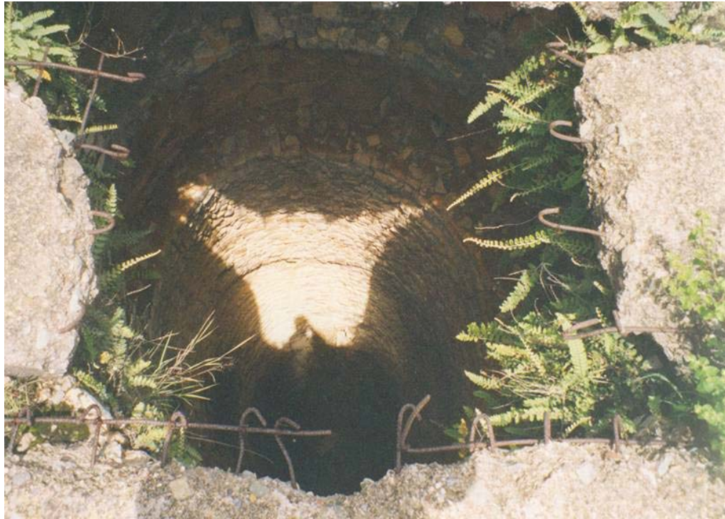
Fotografía 45. Horno de forma cilíndrica vertical, el cual fue utilizado para deshidratar la caliza y con este proceso obtener calidra.
