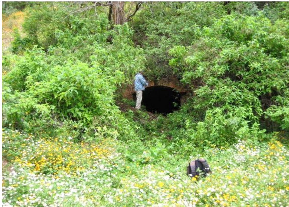
Fotografía 22. Localidad de la mina El Refugio, labrada en una secuencia vulcanosedimentaria, en la comunidad de Mineral de La Luz.
