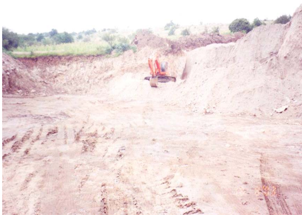
Fotografía 16. Banco de material Tepetate “La Soledad”, municipio Abasolo, Gto.
