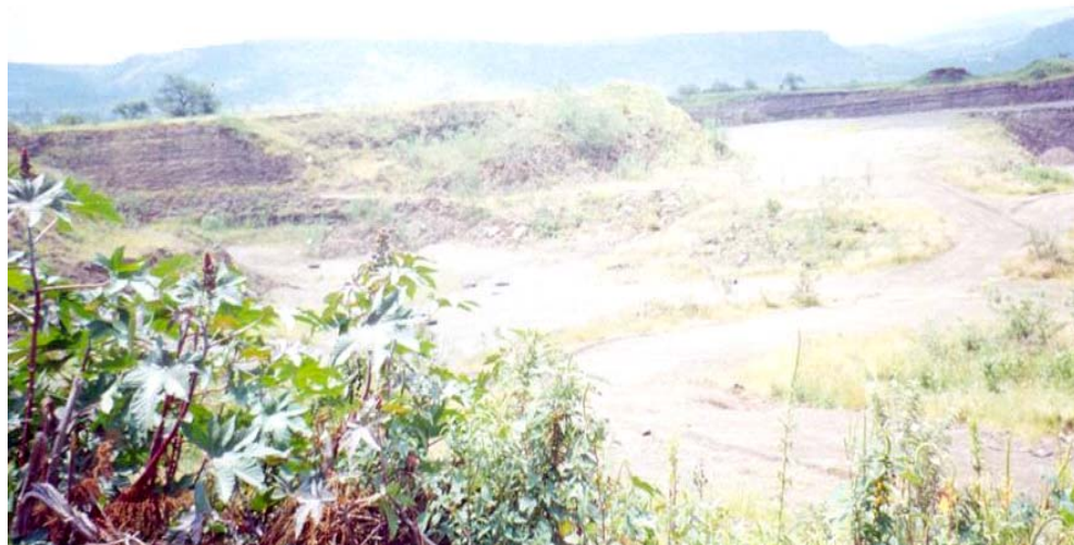
Fotografía 14. Panorámica del banco de material Tepetate “El Saucillo”, municipio Abasolo, Gto.
