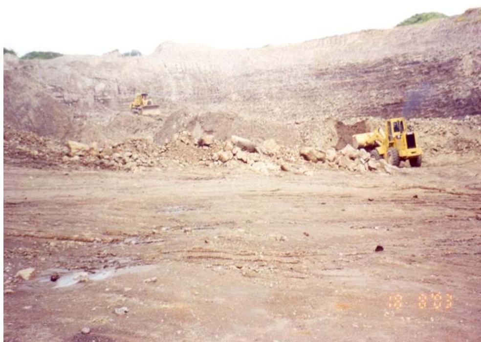
Fotografía 21. Panorámica del banco de material Tepetate “Los Pinos”, municipio Abasolo, Gto.
