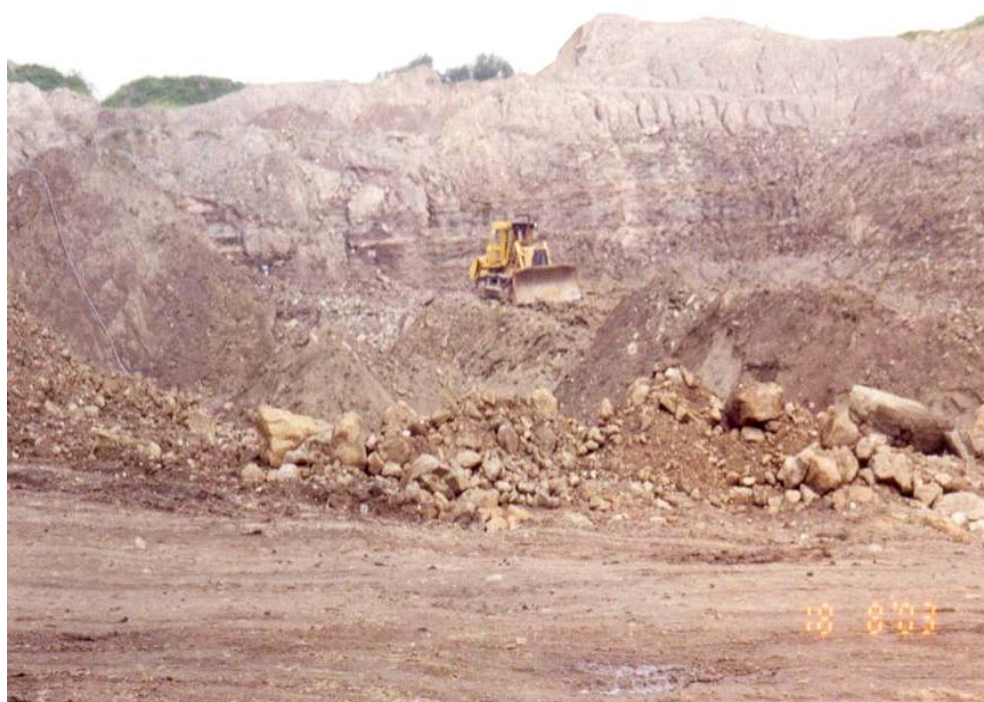
Fotografía 22. Detalle del banco de material tepetate “Los Pinos”, municipio Abasolo, Gto.
