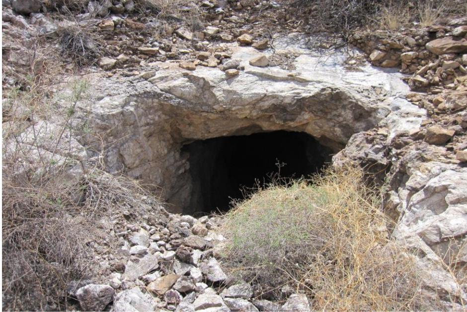
**Fotografía 24.** Socavón crucero de la localidad La Verde II, abierto en calizas de la Formación Finlay.
