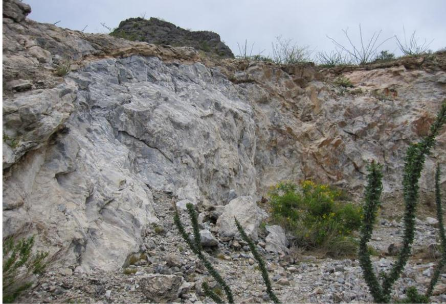
**Fotografía 36.** Tajo de extracción de mármol de la localidad Los Filtros, Mpio. Chihuahua, Chih., en el que se observa las variedades de mármol de la localidad y el grado de fracturamiento del depósito.
