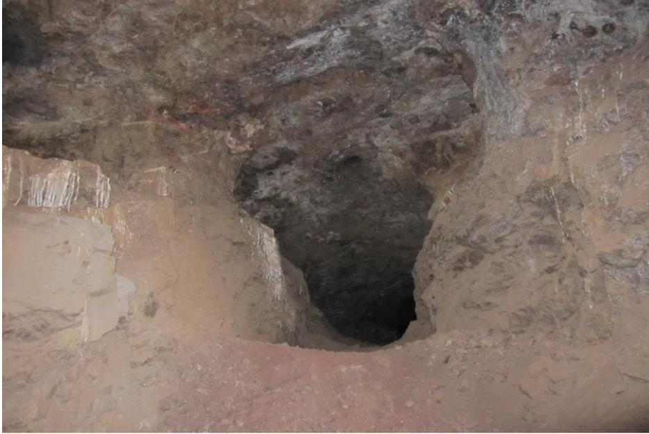
**Fotografía 16.** Interior de la mina La Plomosa I. La obra minera es irregular dirigida a la explotación de un cuerpo de óxidos de aspecto calichoso y terroso, que rellena zonas de fracturamiento de las calizas de la Formación Finlay.
