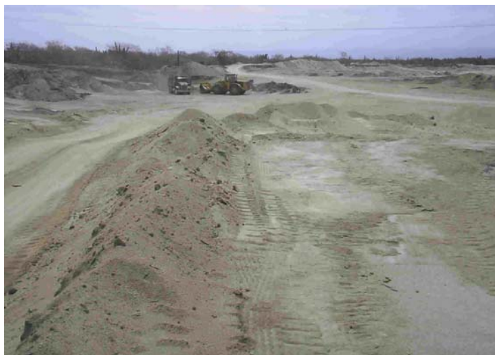
Fotografía 28. Banco de arena arcillo-limosa es utilizado como relleno.
