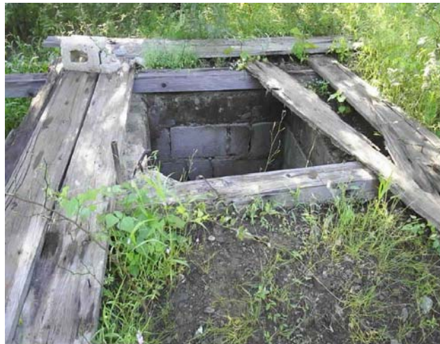
Fotografía 4. Tiro aterrado a rumbo de la estructura mineralizada
