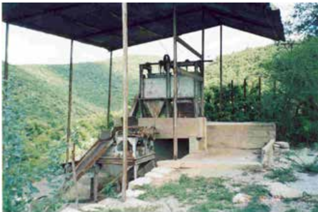
Fotografía No.33. Detalle de las cribas, yicks y temblorinas del antiguo molino de la mina San Juan, vista al NE
