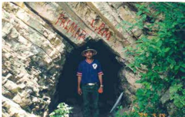
Fotografía 34.- Detalle mostrando el brocal principal de la mina El Palmar, labrado en caliza de la Formación Agua Nueva.
