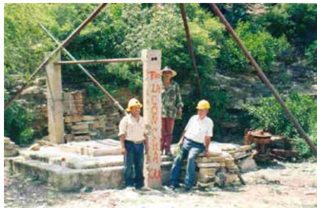
Fotografía 31. Condiciones actuales del brocal del tiro La Concha.
