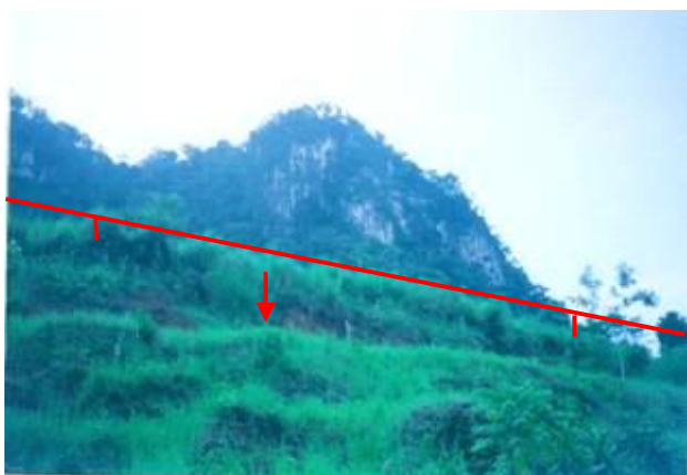
Fotografía 48.- Panorámica donde se puede apreciar el desplazamiento vertical, de la falla Cerro Blanco, en el camino al poblado de Tapijulapa
