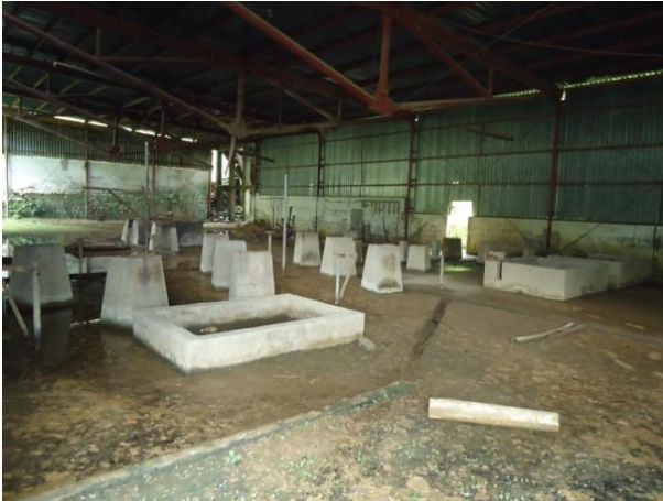
Fotografía 32. Interior de la planta de beneficio de Pluma Hidalgo abandonada, al poniente del poblado del mismo nombre.
