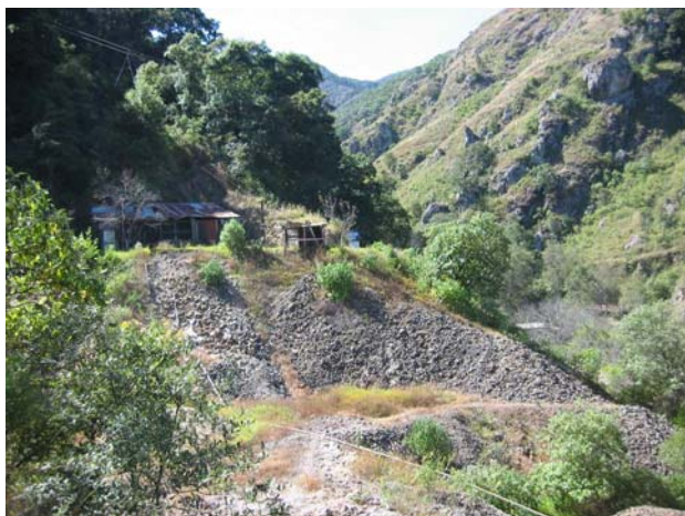
Fotografía No 27.- Mina Atargea se aprecia, terrero e instalaciones abandonadas
