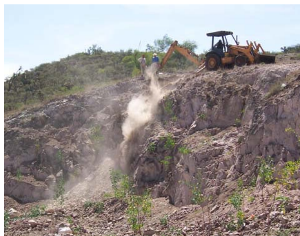
Fotografía No. 34 Preparación del banco San Pedro.
