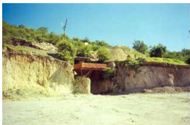
Fotografía 40. Tolva del banco de material Huitzucu donde se cargaba el material utilizado para agregados pétreos, se localiza al occidente de Huitzucu de los Figueroa.
