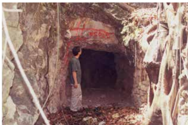
Fotografía 28. Mina La Guillermina, labrada en el contacto entre las formaciones Morelos y Mezcala, al norte de la población de Huahuaxtla.
