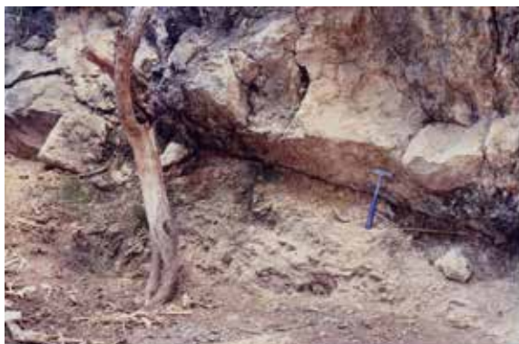
Fotografía 25. Cabalgadura Atzala-Zapoapa, donde se aprecia el contacto por sobreposición de Formación Morelos a la Formación Mezcala.
