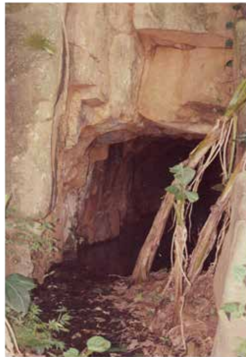
Fotografía 32. Bocamina de la obra El Aguacate labrada sobre granodiorita, esta inundada y con abundante guano, se localiza al sur de la población de Coxcatlán.
