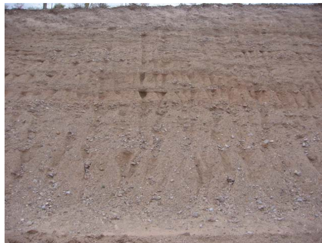
Fotografía 17.- Gravas y arenas constituidas por rocas volcánicas y sedimentarias dispuestas caóticamente en un corte de aproximadamente 8 metros sobre la carretera que conduce al poblado de Manuel Benavides.
