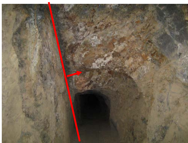
Fotografía 24.- Aspecto del control estructural de la mineralización en el socavón principal de la obra minera Dos Amigos. Viendo al N 10° W.
