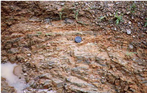
Fotografía 1. Cuarzita. Aspecto general de las rocas del basamento representada por las cuarzitas que están a manera de “colgantes” en la cima del Intrusivo de Jilotlán.
