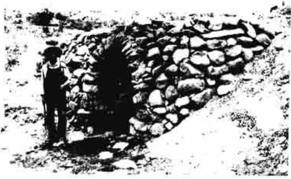
FOT. No. 6.- Horno rústico para fabricar cal viva.
