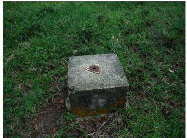
**Fotografía 57.-** Brocal de barreno de la plantilla de barrenación programada por CANGOLD.
